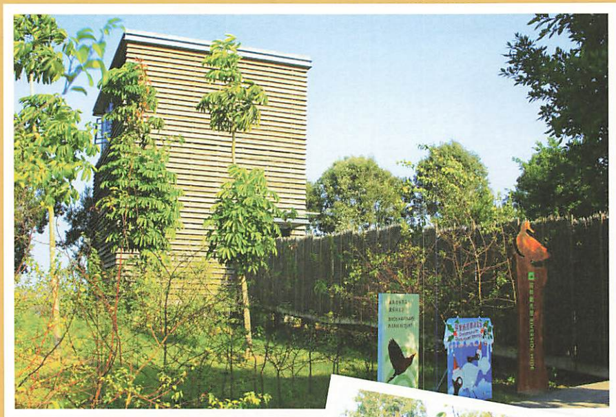
▲三層高的賞鳥屋·鋼骨結構外覆木板·利用太陽能驅動屋內電扇。
