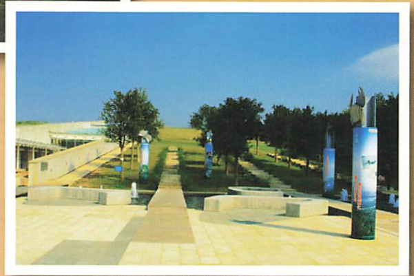
▲遊客中心屋頂覆土植栽，降低屋內熱氣。
