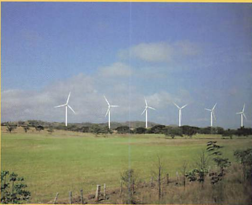
▲ 風力發電設施
