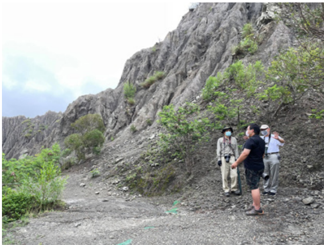
土地表面風化剝落崩塌
