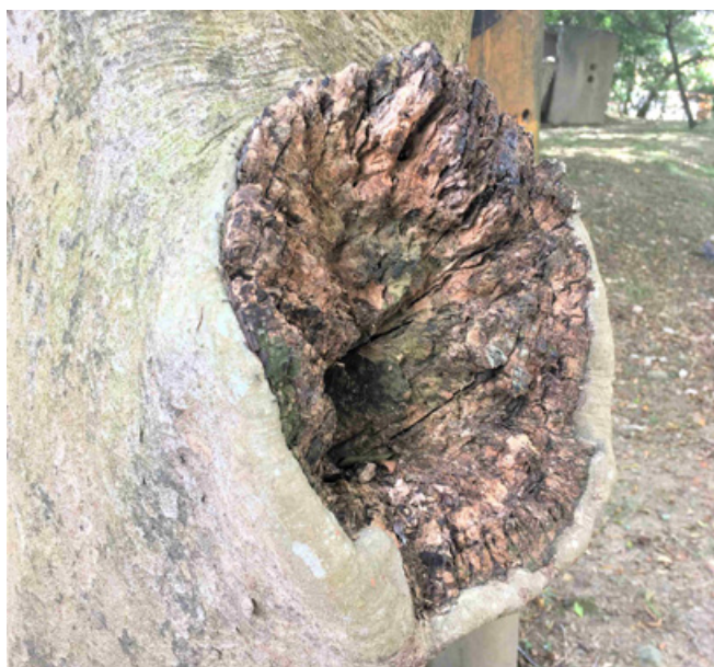
照片 7 腐蝕坑已深入主幹
