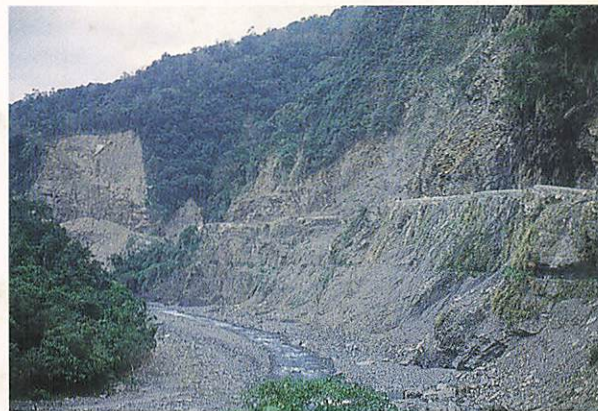
保留區內因地質脆弱，道路崩塌的情形
